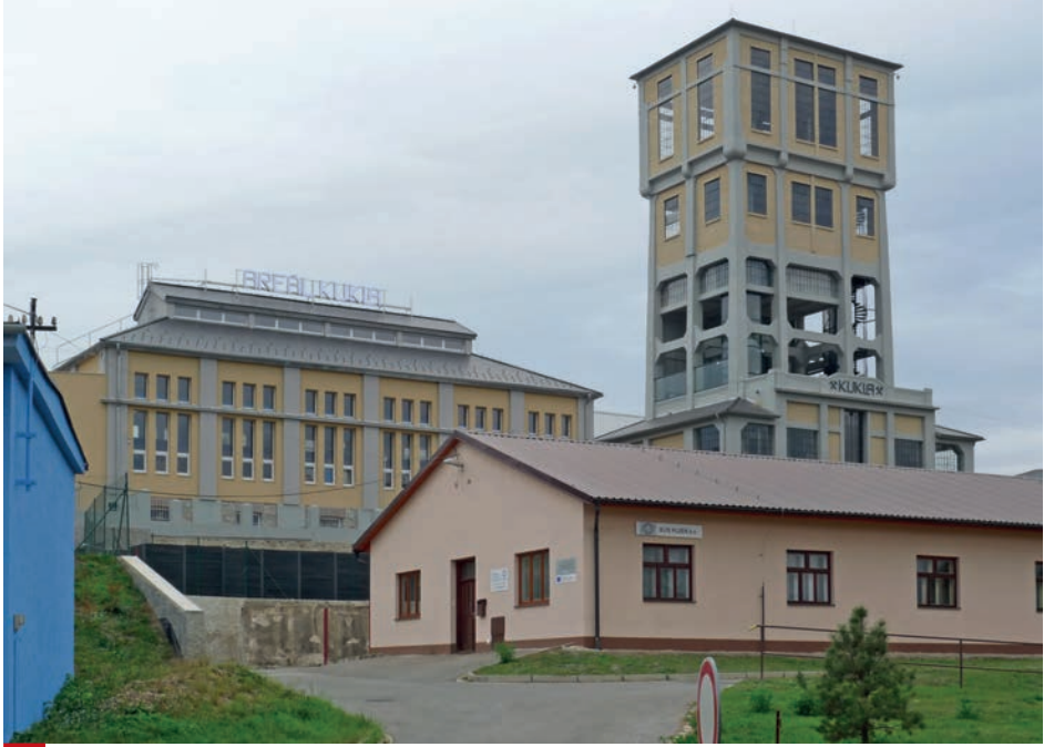
Oslavany, důl Kukla, typologicky zajímavá železobetonová těžní věž z let 1911–1913 je v současné době využívána jako vyhlídková věž a součást zábavního parku Permonium. Foto Miloš Matěj, 2013. • Oslavany, Kukla colliery, this typologically interesting reinforced concrete winding tower (1911–1913) is currently used as a viewing tower and forms part of the “Permonium” theme park. Photograph by Miloš Matěj, 2013.
