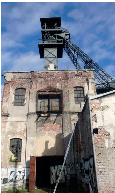
Ostrava-Kunčičky, důl Alexander, těžní věž a jámová budova. Po rekonstrukci těžní věže byl připraven projekt na rekonstrukci jámové budovy do původní podoby. Foto Jana Kynclová, 2015. • Ostrava-Kunčičky, Alexander colliery, winding tower and pit-head building. After the reconstruction of the winding tower, plans were drawn up for the restoration of the pit-head building to its original appearance.
