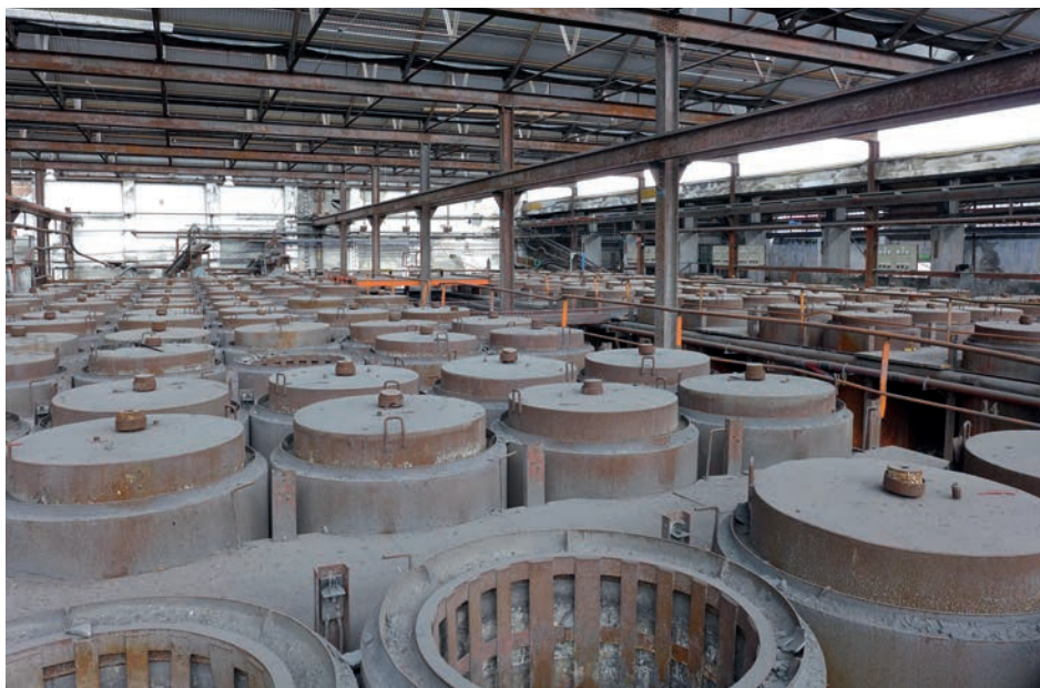
Odda Smelteverk. The 325 Frank-Caro furnaces in the Dicyanamide Plant, made in the 1930'ies for the further processing of the carbide at Odda Smelteverk. Photograph by Miloš Matěj, 2015. • Odda, průmyslový komplex Odda Smelteverk. Celkem 325 pecí typu Frank-Caro na výrobu dikyanamidu, vyrobených ve 30. letech 20. století pro další zpracování karbidu. Foto Miloš Matěj, 2015.
