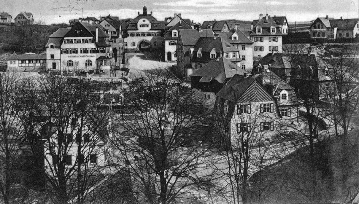
Liberec, rozestavěné Liebiegovo městečko s dokončeným náměstím Pod Branou (Theodorplatz) v roce 1914, soukromá sbírka. • Liberec, the Liebieg Town during construction; the main square (Theodorplatz) was already complete, 1914, private collection.
