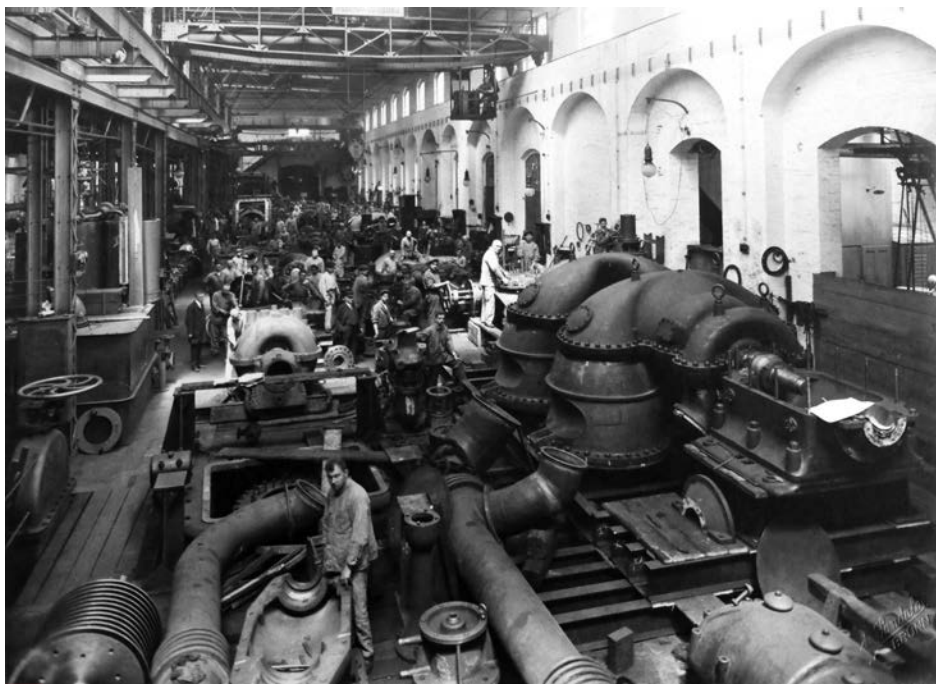
Brno, strojírna Friedrich Wannieck, 20. léta 20. století, montáž kondenzačních parních turbín o výkonu 22 000 HP tzv. BB systému (Bauart Brünn) v jedné ze dvojice hal, vystavěných dle projektu firmy C. Sequin-Bronner. Prostor je v současné době využíván jako galerie výtvarného umění. Moravský zemský archiv v Brně, H863, PBSS, nezpracováno, album 16. • Brno, Friedrich Wannieck engineering works, 1920s, assembly of condensing steam turbines producing 22,000 HP, known as the BB system (Bauart Brünn), in one of the two halls built to a design by the C. Sequin-Bronner studio. The space is currently used as an art gallery. Moravian Provincial Archive, Brno, H863, PBSS, uncatalogued, album 16.
