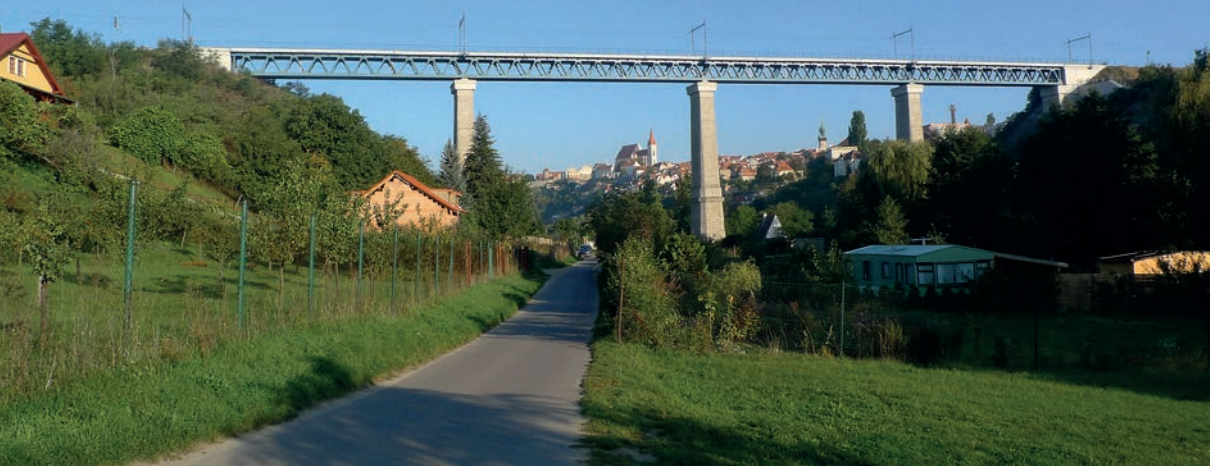
Znojmo, železniční most bývalé Severozápadní dráhy z roku 1871, který vedl trať přes údolí Dyje, nesou tři pilíře vysoké 45–48 m. Původní příhradový nýtovaný nosník dlouhý 220 m byl přemístěn a nahrazen konstrukcí typu ŽM16. Foto Alena Borovcová, 2014. • Znojmo, railway bridge on the former North-West Railway, dating from 1871; it spanned the Dyje valley, and was supported by three pillars (45–48 m high). The original riveted girder (220 m in length) was later moved and replaced by a structure known as the ŽM16 type. Photograph by Alena Borovcová, 2014.
