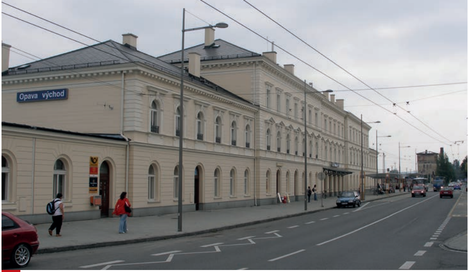
Opava, výpravní budova železniční stanice Opava východ, pohled z přednádraží. Foto Alena Borovcová, 2014. • Opava, passenger building at the Opava východ station, view from outside the station. Photograph by Alena Borovcová, 2014.
