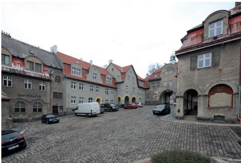
Liberec, Liebiegovo městečko, současný stav náměstí Pod Branou s ukázkou nešetrné obnovy jednoho z domů, fotoarchiv NPÚ, ÚOP v Liberci. • Liberec, the current situation at the main square, showing the insensitive renovation of one of the buildings, photo archive of the National Heritage Institute, Liberec branch.
