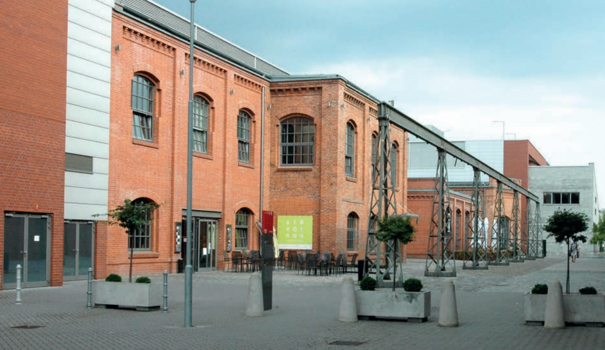
Brno, strojírna Friedrich Wannieck, bývalá slévárna, dnes nákupní Galerie Vaňkova Brno, která v bývalém výrobním objektu sídlí od roku 2005. Foto Květa Jordánová, 2013. • Brno, Friedrich Wannieck engineering works, former foundry, now the "Vaňkova" shopping mall, which has been situated at the former factory since 2005. Photograph by Květa Jordánová, 2013.
