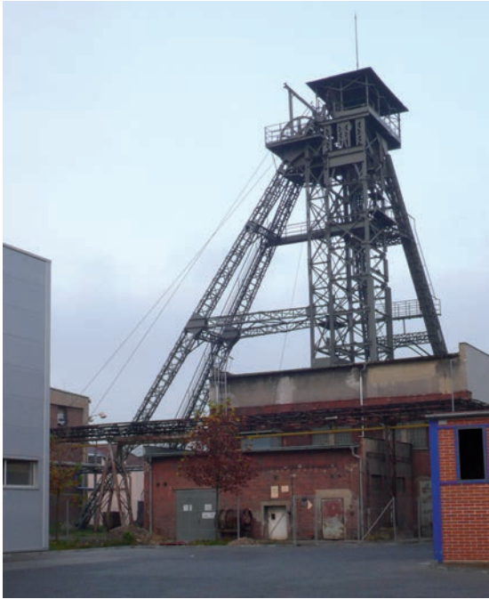
Ostrava, důl Louis, sdružené těžní věže z let 1896 a 1929. Starší z věží je zároveň nejstarší dochovanou těžní věží v revíru. Provoz byl ukončen v roce 1992. Foto Miloš Matěj, 2008. • Ostrava, Louis colliery, interconnected winding towers built in 1896 and 1929. The 1896 tower is the oldest surviving winding tower in the coalfield. The mine was closed in 1992. Photograph by Miloš Matěj, 2008.
