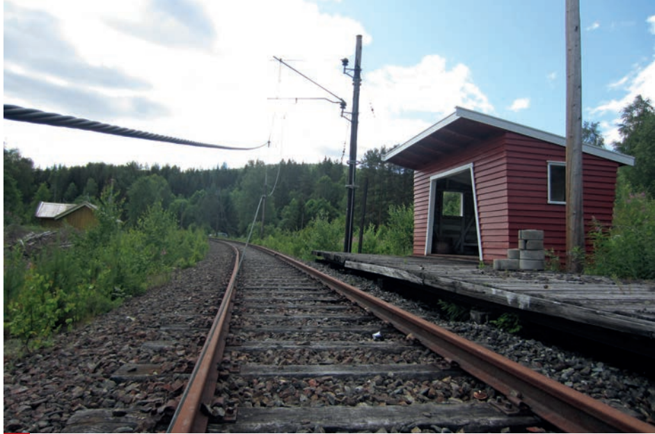
Storemo, stolen copper lines. Photograph by Maria Samudrika Lytomt, 2015. • Storemo, zcizené měděné vedení. Foto Maria Samudrika Lytomt, 2015.
