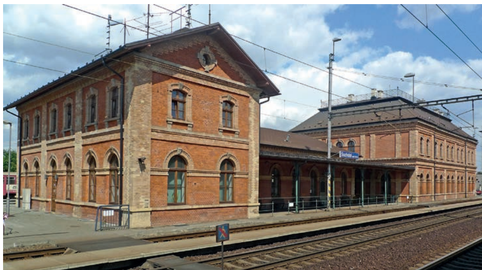
Suchdol nad Odrou, výpravní budova stejnojmenné železniční stanice je v pořadí druhá. Byla postavena v roce 1891 jako ostrovní. Po jedné straně probíhá hlavní trať bývalé Severní dráhy císaře Ferdinanda, na protější straně kolejiště dvou lokální tratí, které postavila tatáž železniční společnost. Foto Alena Borovcová, 2013. • Suchdol nad Odrou, passenger building of the Suchdol nad Odrou railway station, the second building to stand on the site. It was built in 1891 as an island-type structure with tracks on both sides: on one side the main Kaiser Ferdinands-Nordbahn line, and on the opposite side two local lines built by the same company. Photograph by Alena Borovcová, 2013.
