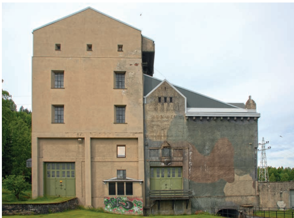
Øvre Eiker, Hakavik hydropower station Second World War camouflage is intact on the south facing façade. Photograph by Ulf Ingemar Gustafsson, 2014. • Øvre Eiker, vodní elektrárna Hakavik, na jižní fasádě jsou zachovány zbytky kamufláže pocházející z druhé světové války. Foto Ulf Ingemar Gustafsson, 2014.
