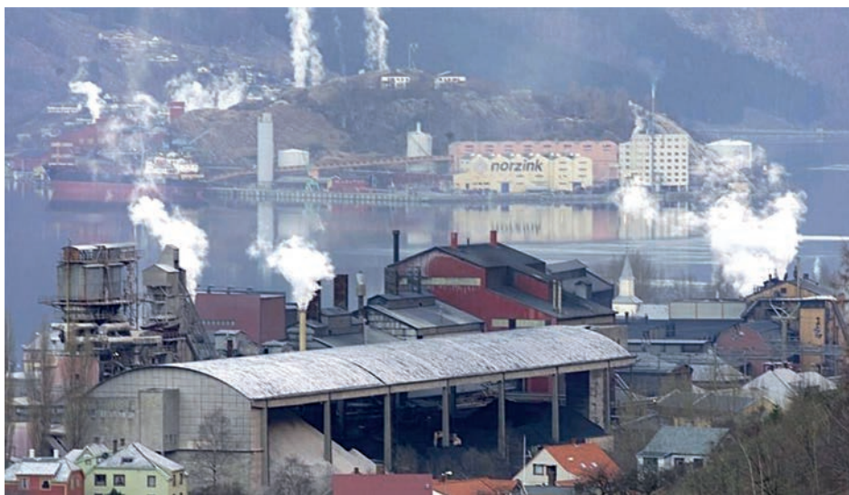
Odda, Smelteverk in 2001. The furnaces that have been demolished are at the left (with smoke). The preserved furnace no. 3 is in the centre, with red cladding. Photograph by Kjell Strand. • Odda, průmyslový komplex Odda Smelteverk v roce 2001. Vlevo pece, které byly později zlikvidovány (s kouřícími komíny), ve středu chráněná pec č. 3 (s červeným opláštěním). Foto Kjell Strand.
