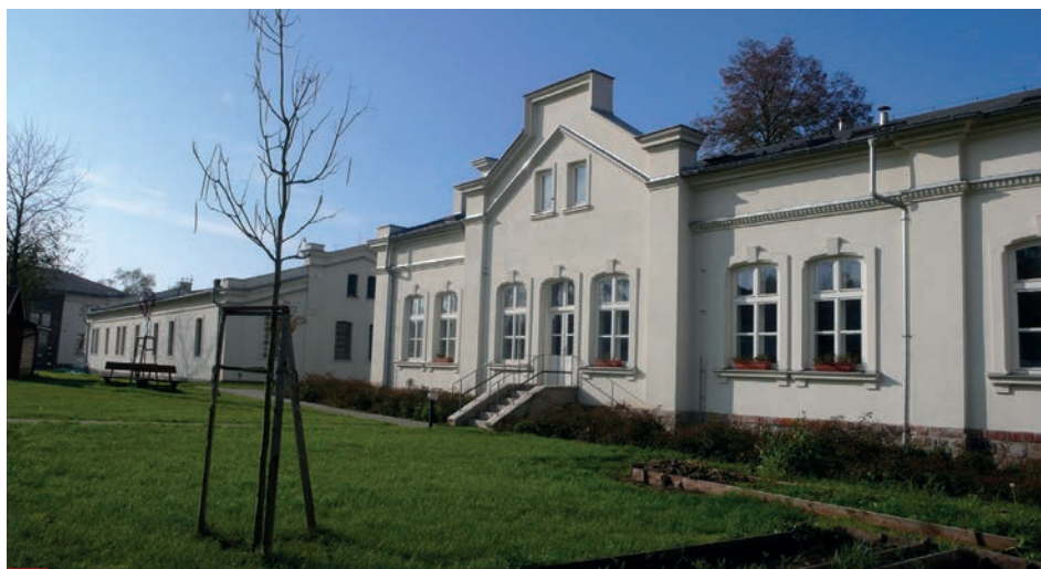
Ostrava-Kunčičky, důl Alexander, část areálu využívá Charita sv. Alexandra, která rehabilitovala objekty dílny s kovárnou, kočárovny a správní budovy do původní architektonické podoby. Foto Jana Kynclová, 2014. • Ostrava-Kunčičky, Alexander colliery, part of the complex is used by the St. Alexander charity foundation, which has restored the former workshop and forge, carriage-works and office building to their original appearance. Photograph by Jana Kynclová.
